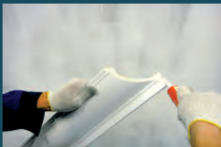
5. На торец изделия нанесите стыковочный клей
