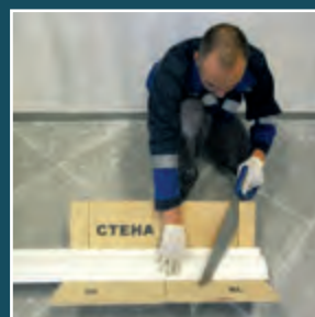
Монтаж лепного декора
