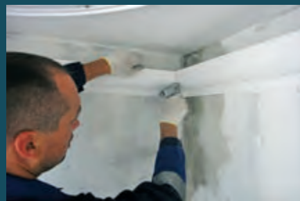
7. Место стыка зафиксируйте строительным степлером
